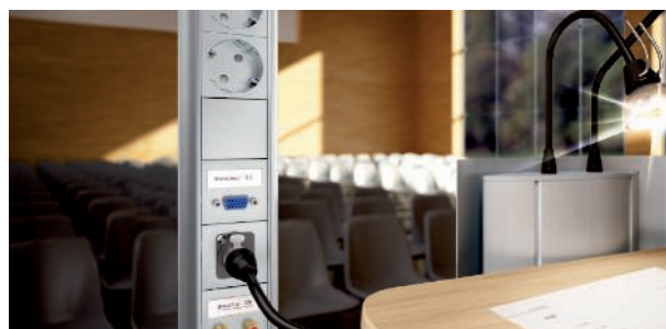
Montáž do instalačních sloupů
