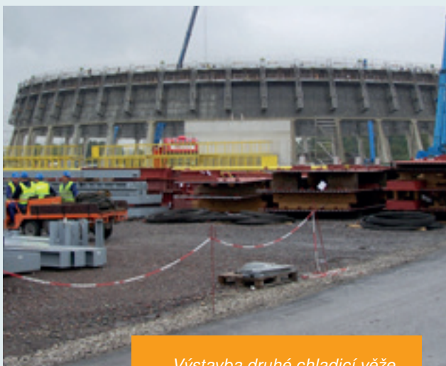
Výstavba druhé chladicí věže
