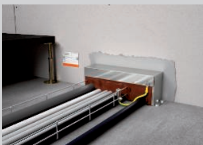
Připojení vyrovnání potenciálů a umístění identifikačního štítku
