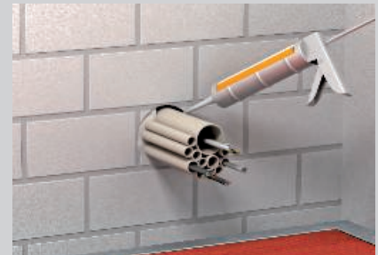
Uzavření kruhových spár intumescentní hmotou DSX.
