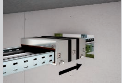
Vsazení krabice do otvoru ve stěně
