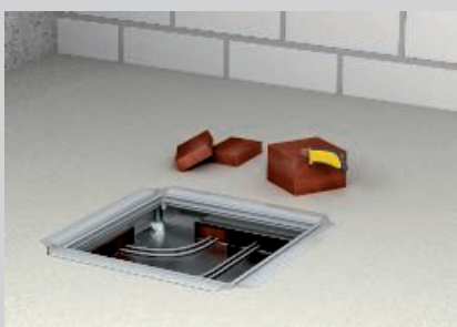
Zaříznutí úzkých pruhů pro komory kanálu.
