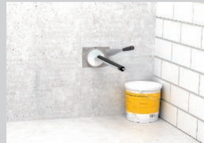
Přizpůsobení pěnové ucpávky instalacím nožem a prostřednictvím povrchové úpravy ablační hmotou ASX nepropouštějící zplodiny hoření.
