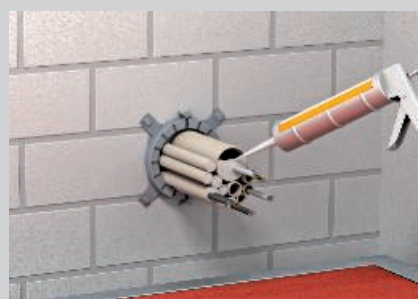
Uzavření konců trubek intumescentní hmotou DSX.
