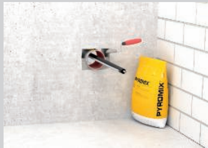
Uzavření otvoru maltou PYROMIX®.
