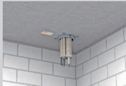
Montáž na spodní stranu stropu pomocí kovových kotev.
