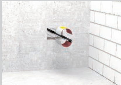
Montáž obalové trubky secvaknutím poloskořepin kolem stávající instalace.
