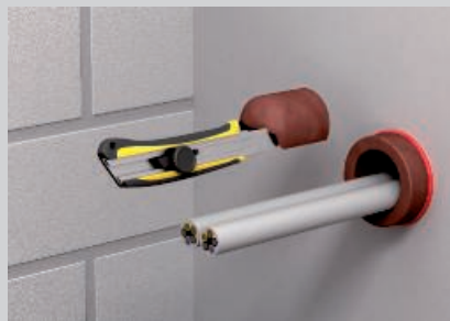
Zařízení a vložení ucpávek do obalové trubky.
