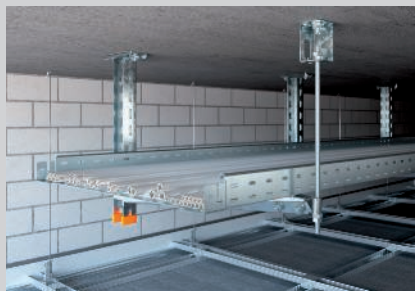
Zavěšení na strop v jedné vrstvě.
