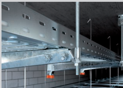
Montáž zajišťovacích závitových tyčí na konec výložníku pomocí připojovacího dílu.
