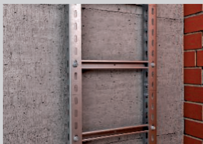
Přímá montáž stoupací trasy na masivní stěnu.
