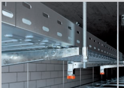
Montáž zajišťovacích závitových tyčí na konec výložníku pomocí přípojovacího dílu.
