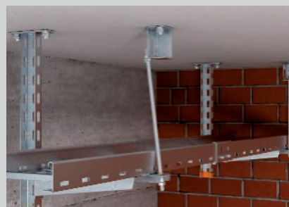
Zavěšení závitové tyče do protipožárního třmenu.
