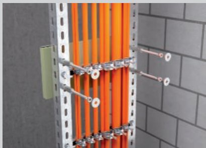
Montáž závitových tyčí, kontramatic a podložek pro upevnění pouzdra.
