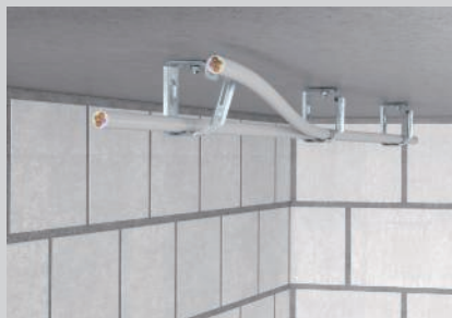
Otevření svazkového držáku a vložení kabelů.
