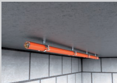
Montáž pod strop.
