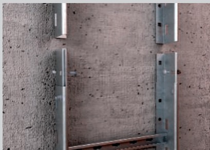
Spojení míst styku pomocí přišroubované spojky.
