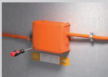
Uzavření krabice víkem a umístění identifikačního štítku.
