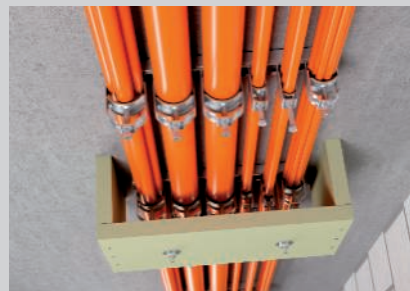
Montáž přes profilové lišty.
