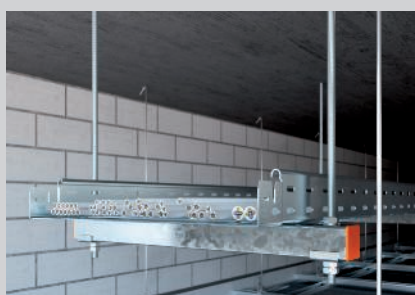
Jednovrstvá montáž na strop nad zavěšeným protipožárním stropem.
