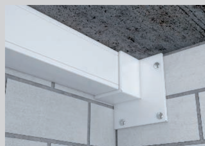
Montáž do rohu místnosti.
